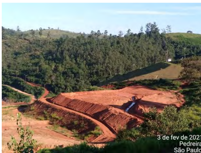
Foto 466 – Bota-espere espaldares sobreposto ao bota-fora I - Margem Direita. (Data:03/02/2021)
