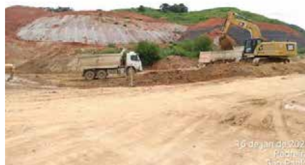
Foto 440 – Movimentação de rocha na margem direita. (Data:16/01/2021)
