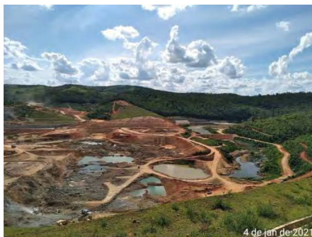
Foto 437 – Movimentação de rocha e terra do empreendimento. (Data:04/01/2021)
