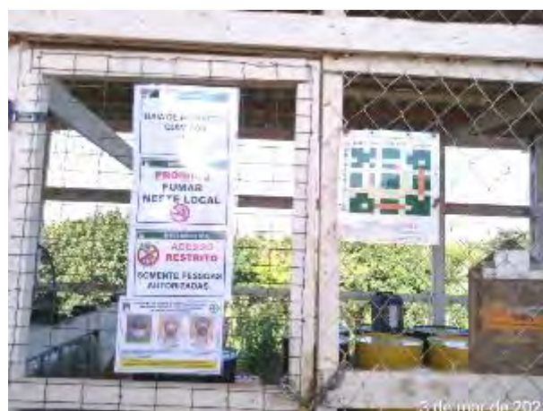
Foto 66 – Baia de produtos químicos no pátio da oficina mecânica. (Data:03/03/2021)
