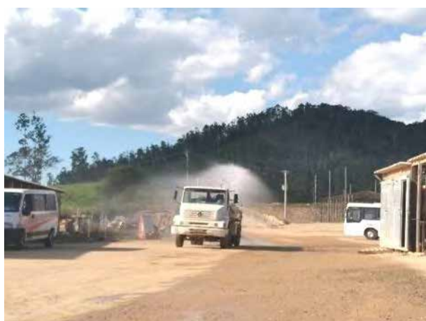
Foto 387 – Umectação nas vias internas. (Data:08/04/2021)
