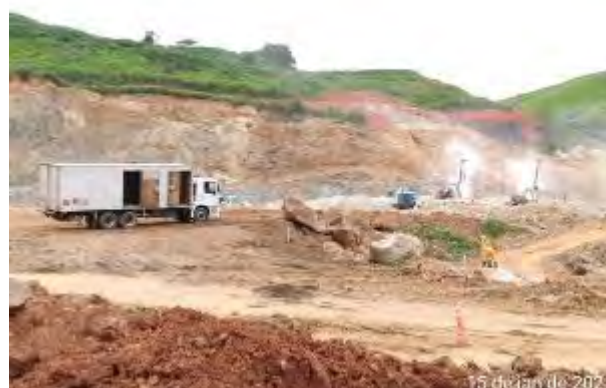
Foto 160 – Área de carregamento dos explosivos para o desmonte de rocha. (Data:15/01/2020)
