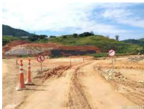
Foto 268 – Sinalização de sentido de via - margem esquerda. (Data:07/04/2021)
