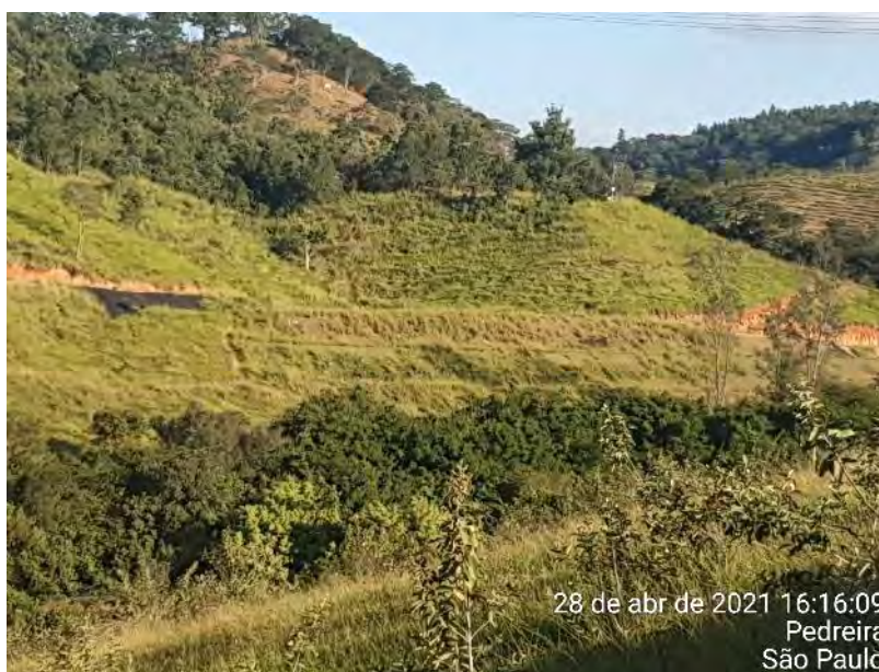
Foto 470 – Bota-fora V margem direita. (Data:28/04/2021)
