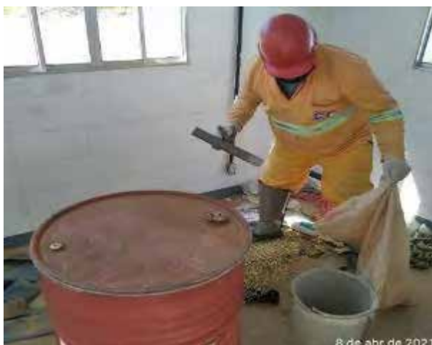
Foto 109- Limpeza e organização da guarita do canteiro operacional. (Data:08/04/2021)
