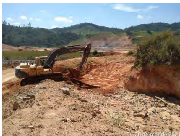
Foto 337 – Limpeza de cacimba – acesso bota-fora II M.E. (Data:26/03/2021)
