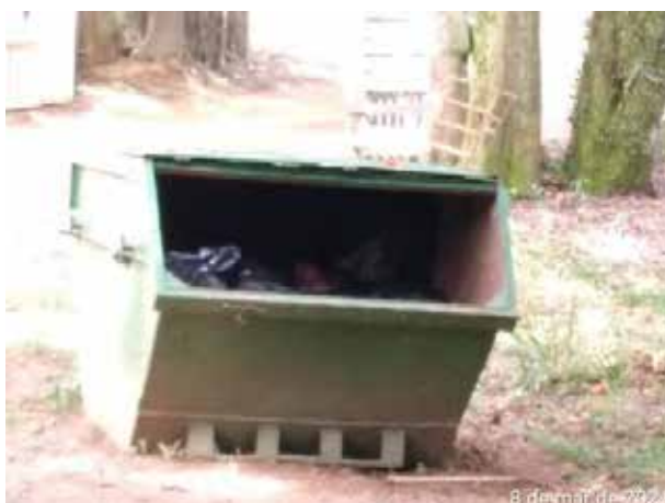
Foto 423 – Caçamba de resíduos comum no canteiro administrativo. (Data:08/03/2021)
