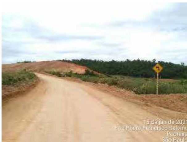
Foto 257 – Sinalização de curva acentuada a esquerda. (Data:15/01/2021)
