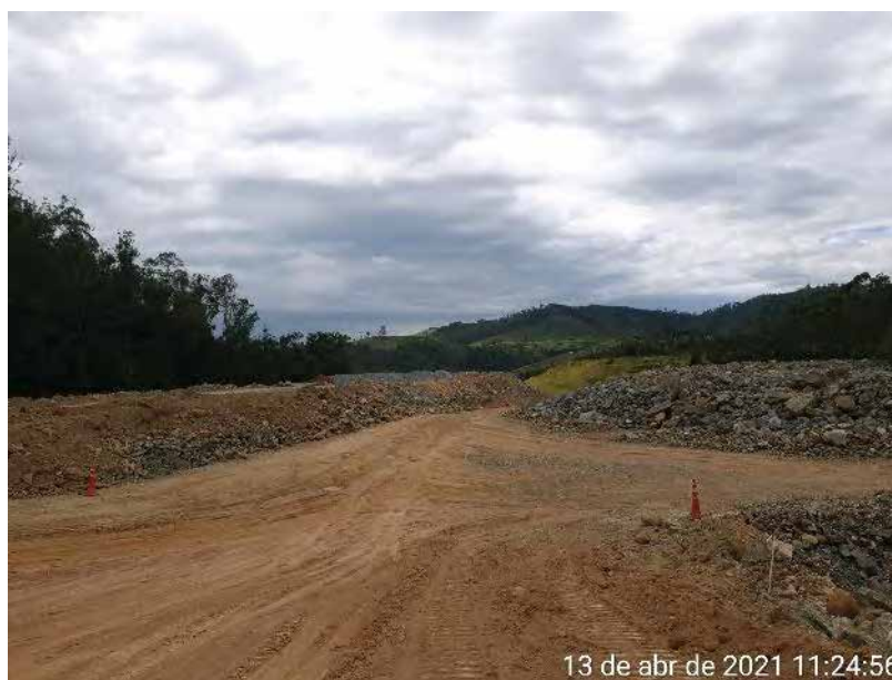
Foto 473 – Bota-espera de rocha sobreposto ao bota-fora II margem esquerda. (Data:13/03/2021)
