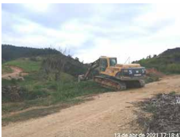
Foto 347 – Limpeza de cacimba – bota-fora III M.D. (Data:13/04/2021)
