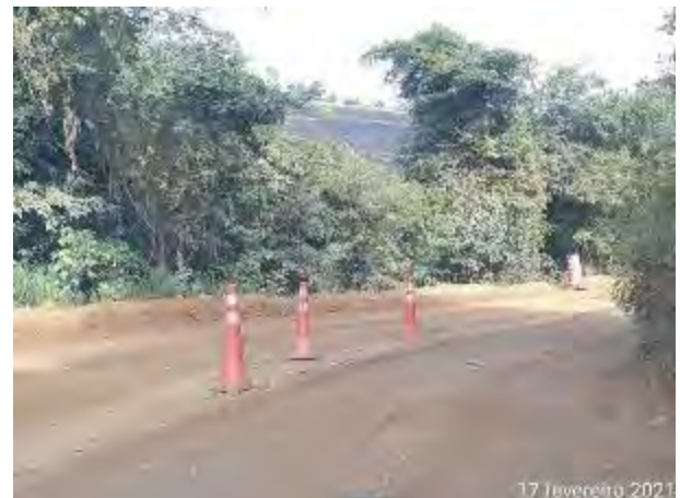
Foto 262 – Sinalização com cones no acesso a área do eixo.. (Data:17/02/2021)
