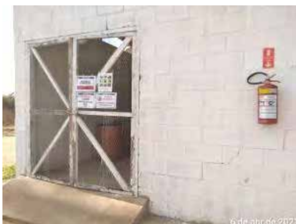
Foto 69 – Baía de resíduos perigosos no canteiro operacional. (Data:06/04/2021)
