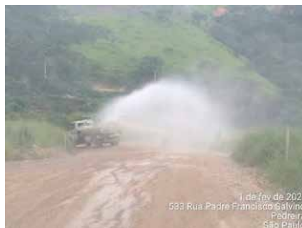
Foto 380 – Umectação nas vias internas. (Data:01/02/2021)
