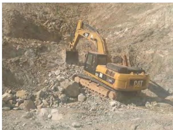
Foto 459 – Movimentação de terra e rocha - margem direita. (Data:09/04/2021)
