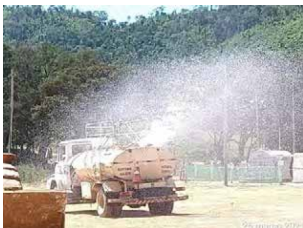
Foto 385 – Umectação nas vias internas. (Data:25/03/2021)
