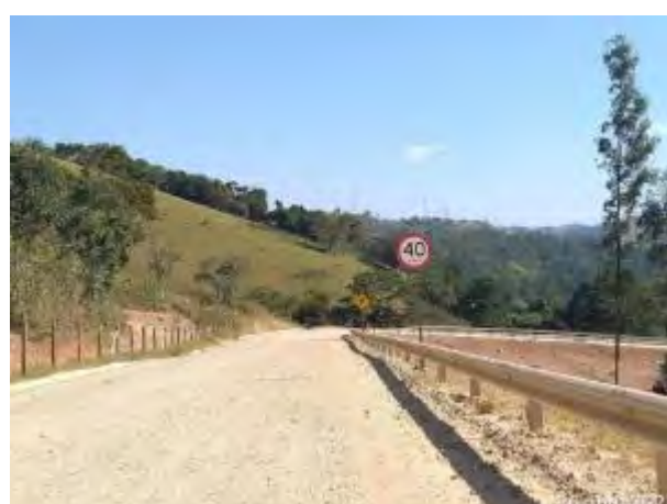
Foto 254 – Sinalização de limite de velocidade na estrada municipal de pedra. (Data:26/04/2021)
