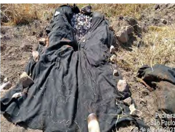
Foto 363 – Dispositivo de drenagem para efluente do processo de sondagem. (Data:30/04/2021)
