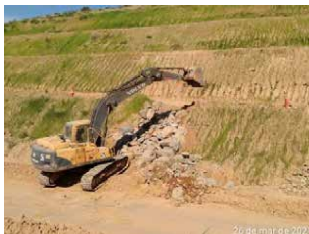
Foto 340 – Regularização de talude – acesso bota-fora II na M.E. (Data:26/03/2021)
