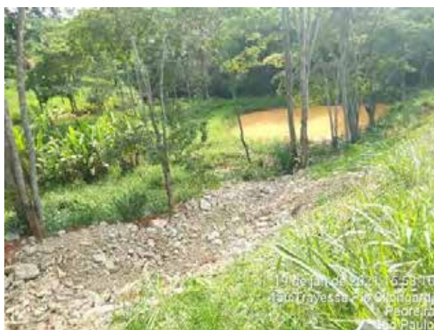
Foto 301 – Canaleta em pedra no acesso M.D. 03. (Data:19/01/2021)
