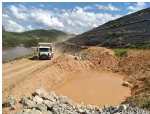
Foto 300 – Inspeção em cacimba instalada no bota-fora I margem esquerda. (Data:05/01/2021)
