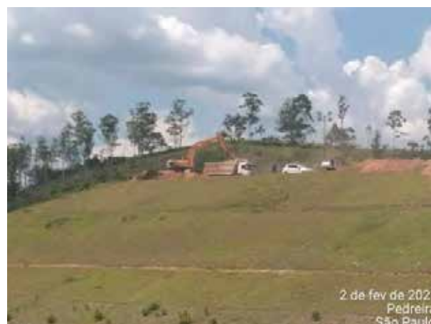
Foto 444 – Movimentação de terra na margem esquerda. (Data:02/02/2021)
