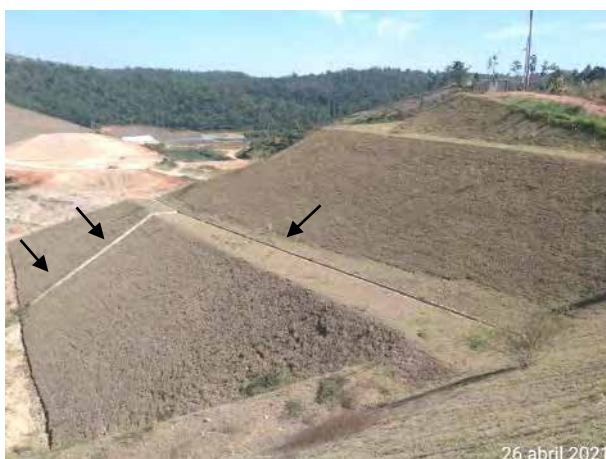
Foto 295 – Canaletas instaladas em talude de corte na ombreira direita. (Data:26/04/2021)
