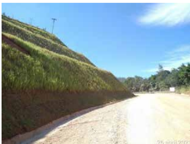
Foto 351 – Inspeção em talude - acesso MD 03. (Data:26/04/2021)
