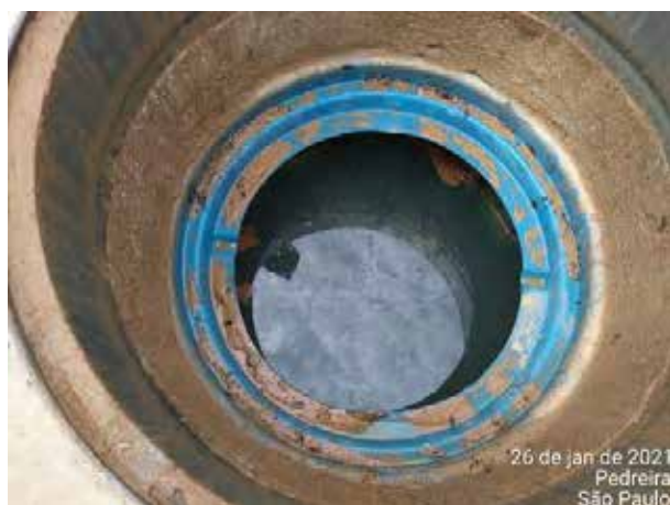
Foto 355 – Inspeção caixa separadora de água/óleo 2. (Data:26/01/2021)
