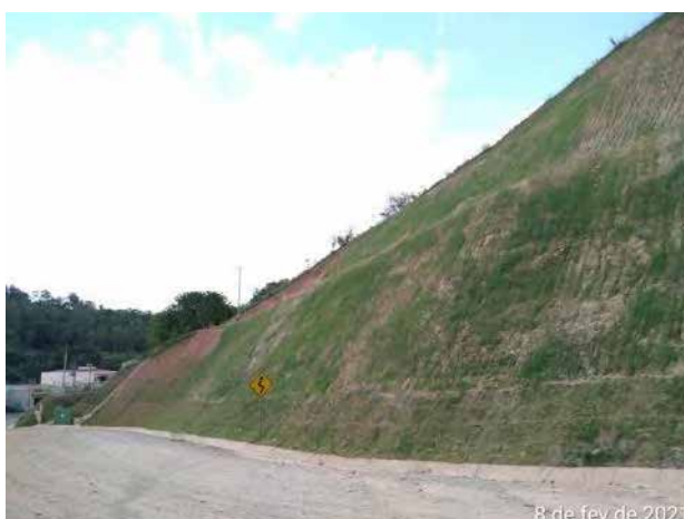
Foto 321 – Inspeção de talude no acesso MD03. (Data:08/02/2021)
