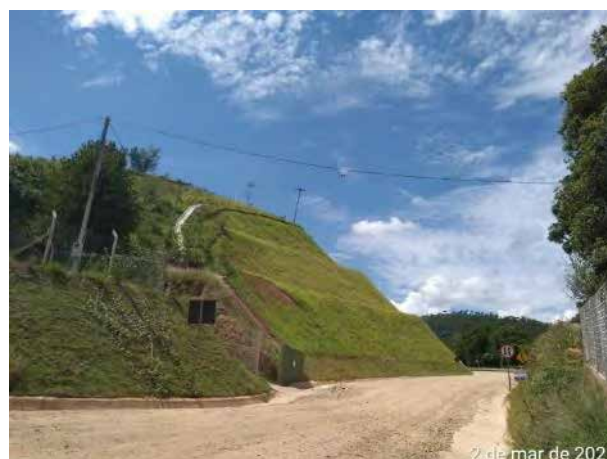
Foto 332 – Inspeção de talude após chuva - acesso M.D.03. (Data:02/03/2021)
