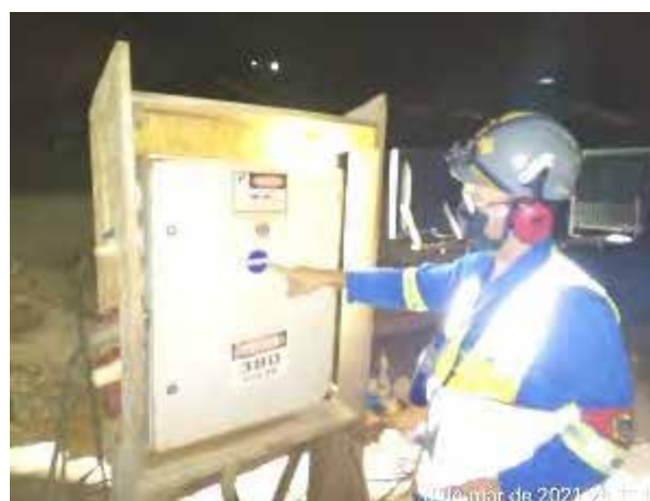
Foto 152 – Inspeção em painel elétrico. (Data:08/03/2021)
