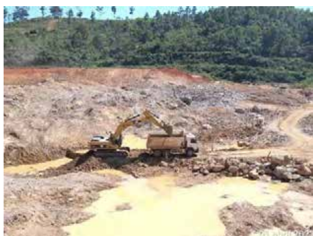
Foto 455 – Movimentação de terra - margem direita. (Data:01/04/2021)
