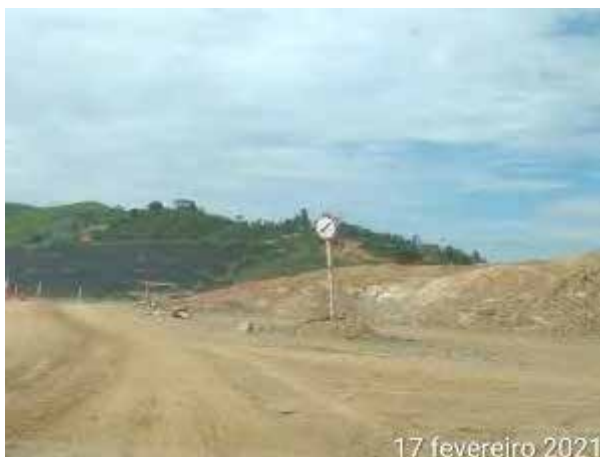
Foto 263 – Sinalização de sentido obrigatório de via interna. (Data:17/02/2021)
