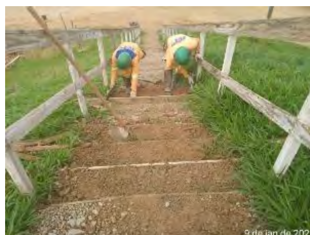
Foto 88- Limpeza e organização no acesso ao vestiário do canteiro operacional. (Data:09/01/2021)
