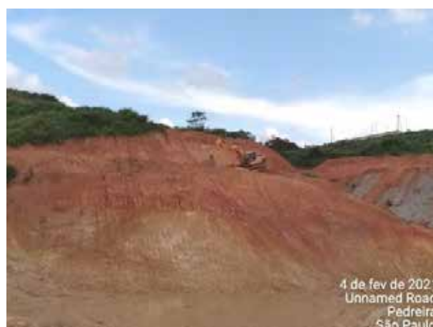
Foto 330 – Regularização de talude na área de corte MD. (Data:04/02/2021)
