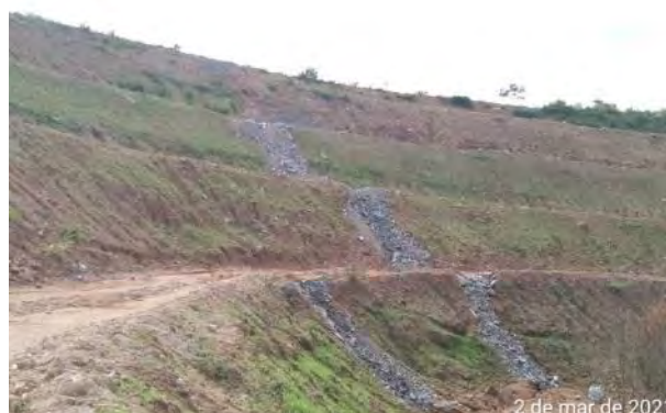
Foto 331 – Regularização de talude - bota fora II M.E. (Data:02/03/2021)
