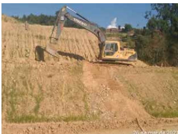
Foto 341 – Regularização de talude – acesso bota-fora II na M.E. (Data:26/03/2021)
