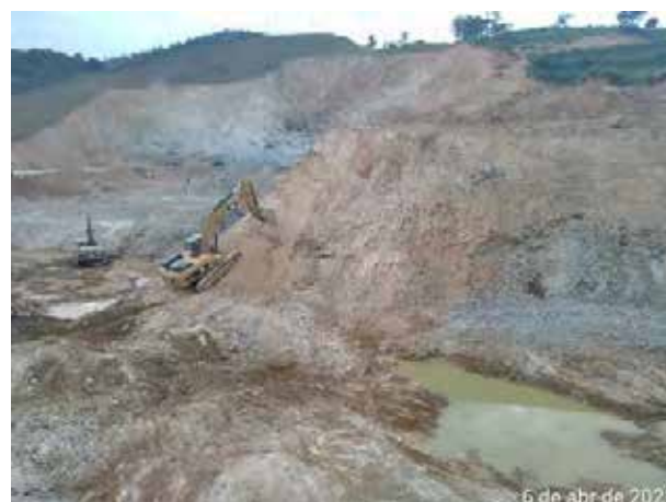
Foto 458 – Movimentação de terra - margem esquerda. (Data:06/04/2021)
