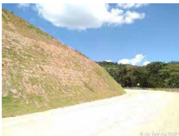
Foto 319 – Inspeção de talude no acesso MD03. (Data:08/02/2021)
