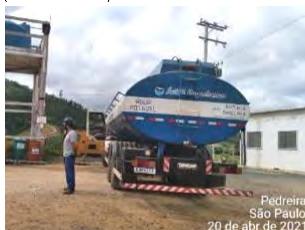
Foto 132 – Abastecimento de água potável no canteiro operacional. (Data:20/04/2021)
