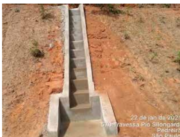
Foto 281 – Escada hidráulica - talude do acesso MD 01. (Data:22/01/2021)
