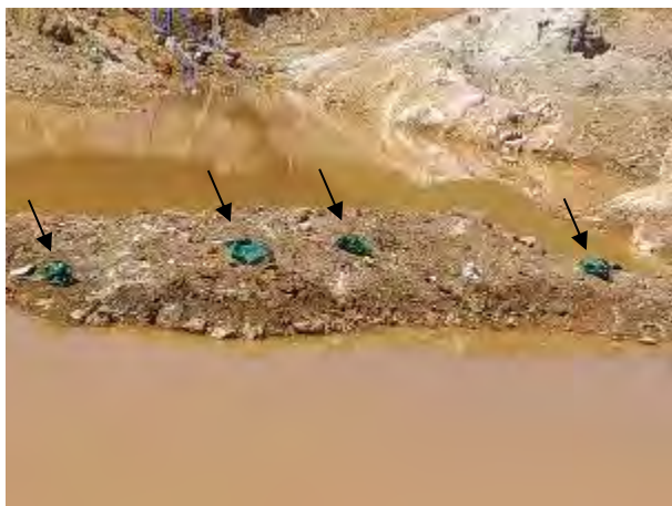
Foto 135 – Reaproveitamento de capa de fardo de hidrosseadura para sinalização de segurança dos explosivos do desmonte e rochas. (Data:27/01/2021)
