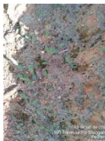
Foto 304 – Inspeção em talude com hidrossemeadura no acesso M.D. 03. (Data:19/01/2021)
