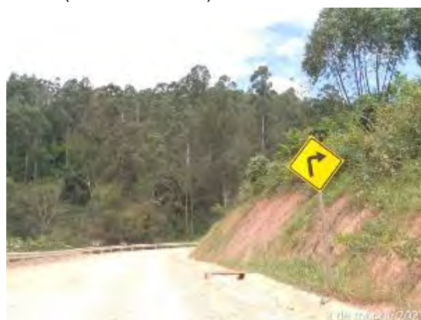
Foto 248 – Sinalização de curva acentuada a direita na MD03. (Data:03/03/2021)
