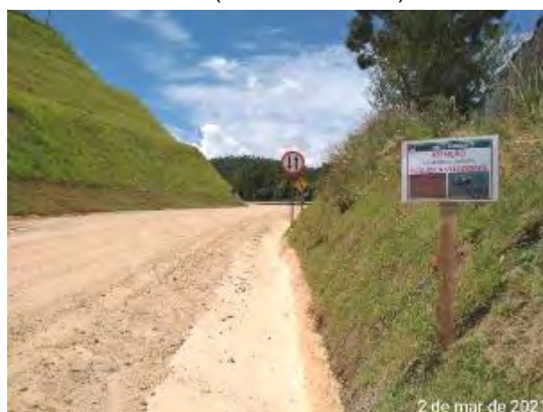
Foto 247 – Sinalização de sentido de via dupla e de atenção para travessia de animais silvestres no acesso da MD03. (Data:02/03/2021)
