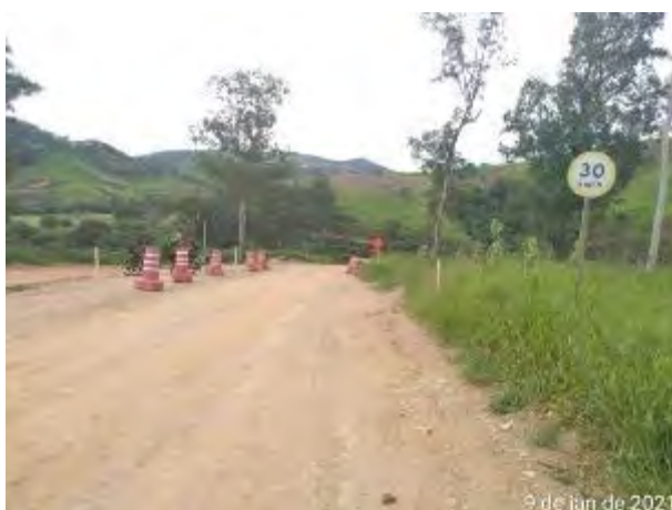
Foto 241 – Sinalização com cones e placa de limite de velocidade. (Data:09/01/2021)
