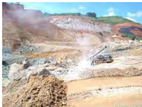
Foto 168 – Perfuração das rochas para o desmorte de rochas. (Data:09/03/2021)
