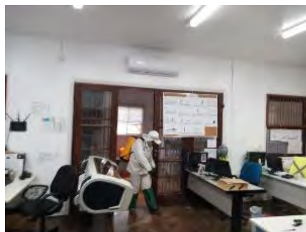
Foto 96- Dedetização e desratização no canteiro administrativo. (Data:06/02/2021)
