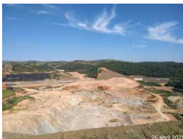
Foto 461 – Movimentação de terra e rocha - margem direita. (Data:26/04/2021)
