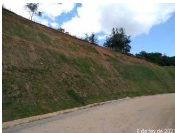
Foto 320 – Inspeção de talude no acesso MD03. (Data:08/02/2021)
