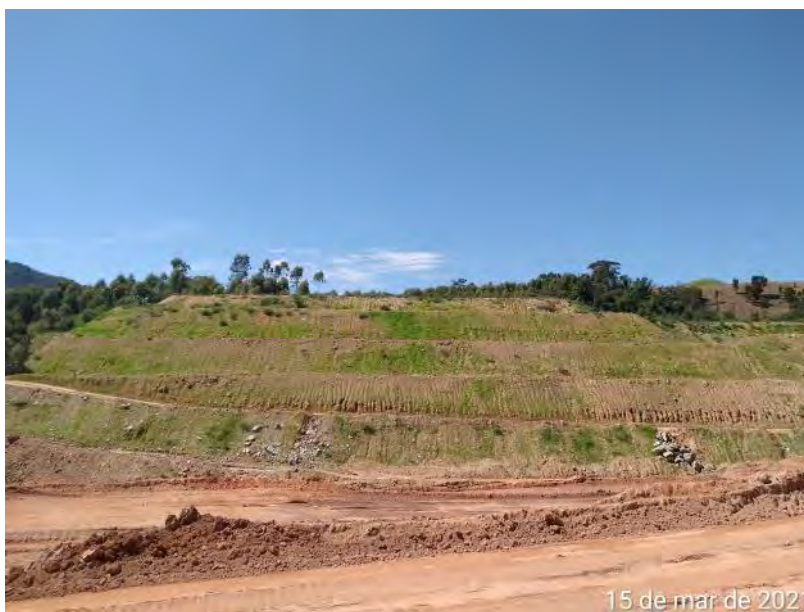
Foto 474 – Bota-fora II A margem esquerda. (Data:15/03/2021)
