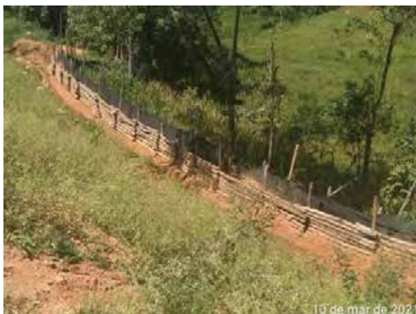
Foto 287 – Dispositivo de contenção ambiental no acesso MD03. (Data:10/03/2021)
