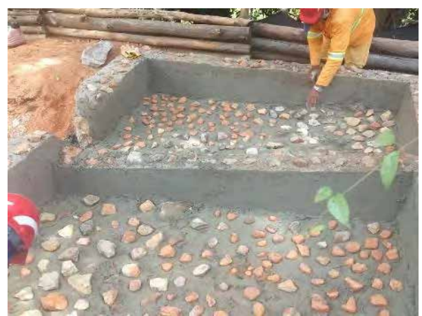
Foto 288 – Instalação de dispositivo de dissipação de água pluvial. (Data:22/03/2021)
