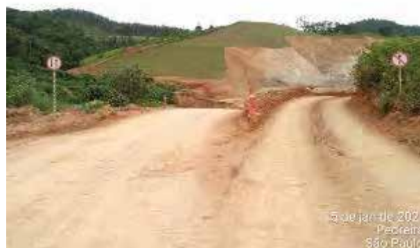
Foto 256 – Sinalização de sentido de via e sentido obrigatório em via interna na margem direita. (Data:15/01/2021)
