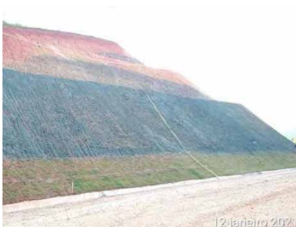
Foto 279 – Utilização de hidrossemeadura em talude da MD 03. (Data:12/01/2021)
