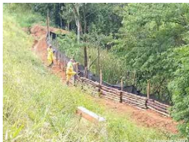
Foto 328 – Reforço na estrutura da contenção ambiental com madeiras. (Data:25/02/2021)
