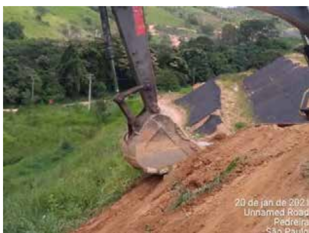
Foto 305 – Regularização de talude no. Bota-fora VII MD. (Data:20/01/2021)
