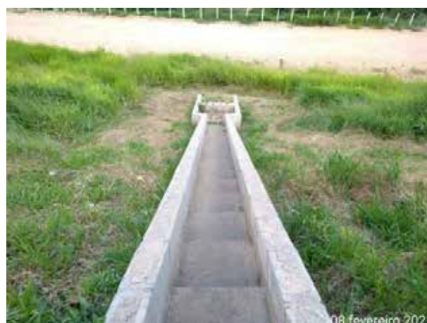
Foto 282 – Escada hidráulica no canteiro operacional. (Data:08/02/2021)
