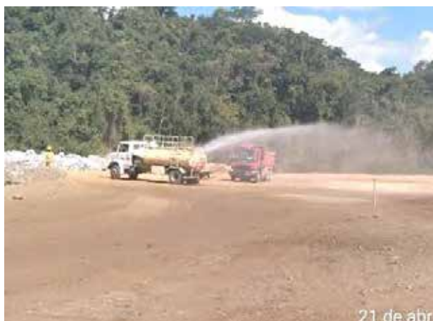
Foto 389 – Umectação nas vias internas. (Data:21/04/2021)
