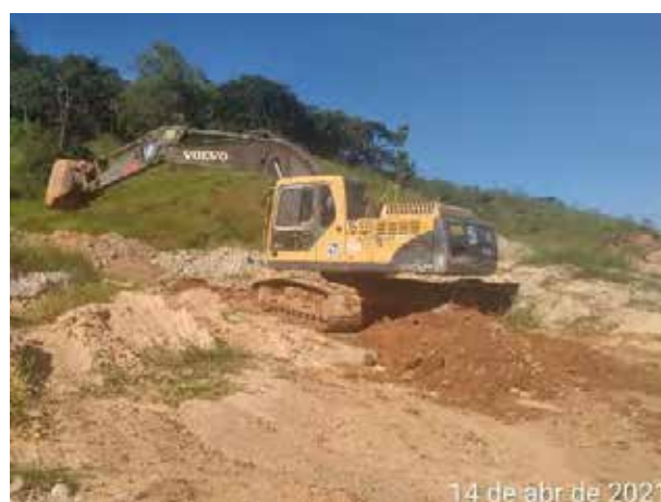
Foto 350 – Regularização de erosões – bota-fora III M.D. (Data:14/04/2021)
