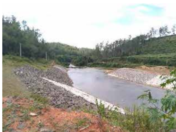
Foto 336 – Inspeção nas margens do canal de desvio. (Data:03/03/2021)
