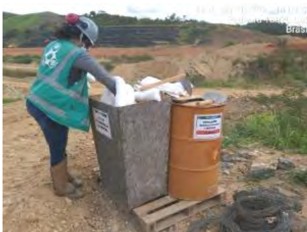
Foto 83 – Abastecimento de kit de emergência ambiental na obreira direita. (Data:14/04/2021)
