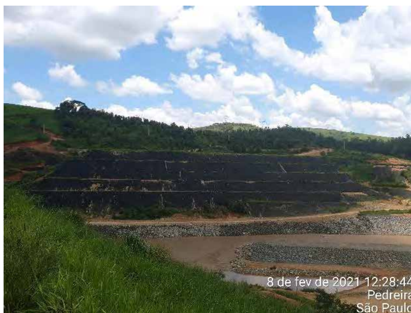
Foto 472 – Bota-fora I margem esquerda. (Data:08/02/2021)
