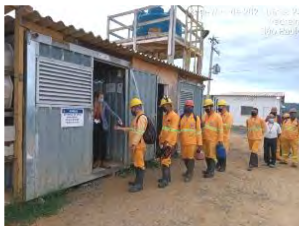
Foto 180 – Aferição de temperatura no canteiro operacional. (Data:03/03/2021)
