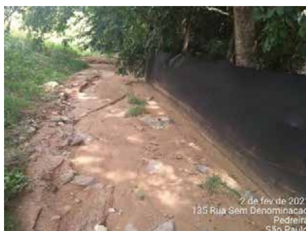
Foto 329 – Inspeção em contenção ambiental. (Data:02/02/2021)
