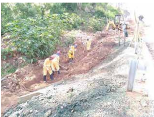
Foto 280 – Construção de canaleta paralela ao acesso MD 03. (Data:14/01/2021)
