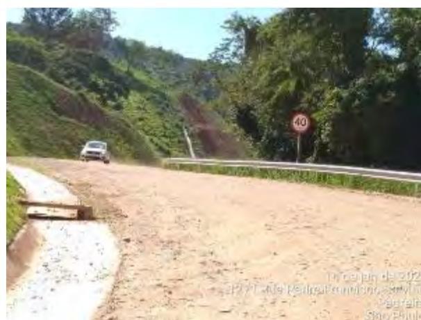
Foto 242 – Sinalização com placas de limite de velocidade no acesso MD01. (Data:14/01/2021)
