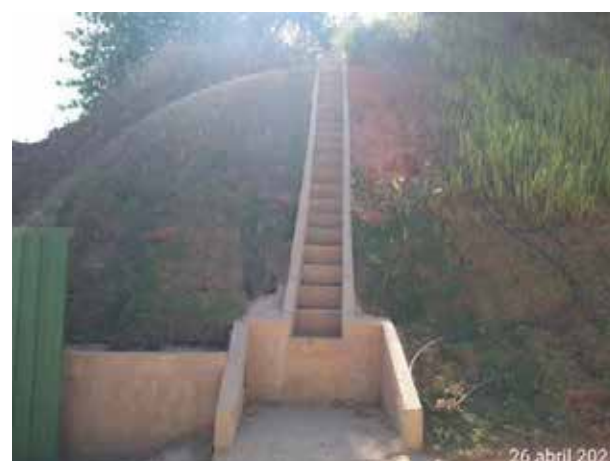
Foto 294 – Escada hidráulica em talude do acesso MD03. (Data:26/04/2021)
