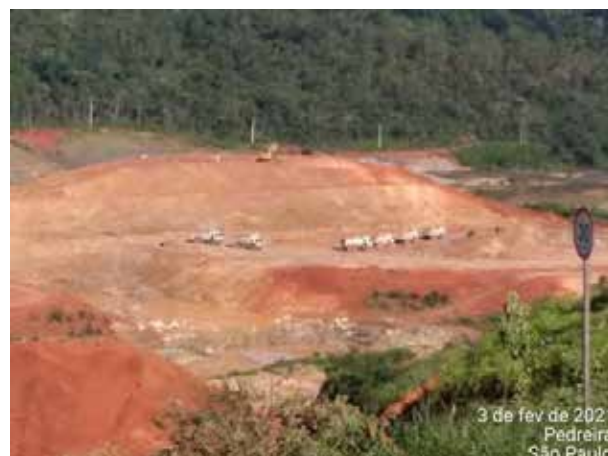
Foto 446 – Movimentação de terra na margem esquerda. (Data:03/02/2021)
