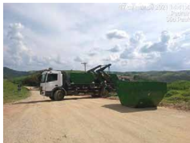
Foto 428 – Troca de caçambas de resíduo comum no canteiro operacional. (Data:17/03/2021)
