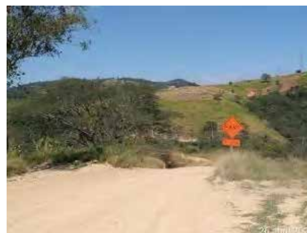
Foto 274 – Sinalização de pare no acesso a estrada municipal de pedreira. (Data:26/04/2021)
