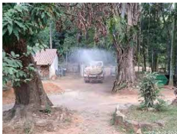
Foto 390 – Umectação nas vias internas. (Data:27/04/2021)
