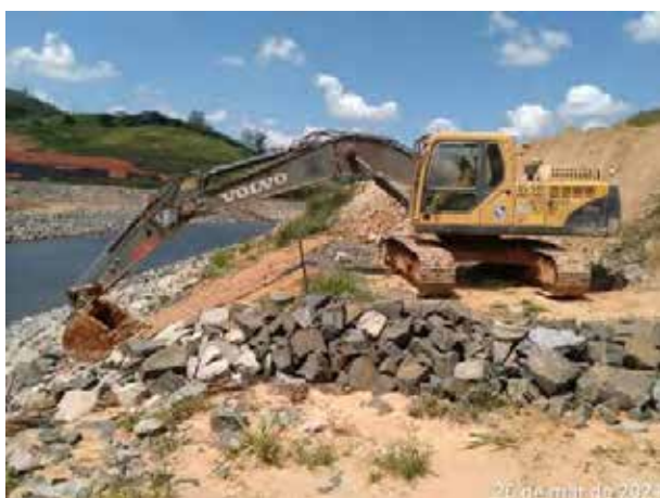
Foto 339 – Regularização de erosão – bota-fora I M.E. (Data:26/03/2021)
