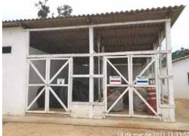
Foto 431 – Baía de resíduos recicláveis (papel, plástico e pneu) - canteiro operacional. (Data:18/03/2021)
