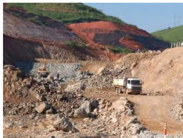
Foto 452 – Movimentação de terra e rocha na margem direita próximo ao eixo. (Data:13/03/2021)
