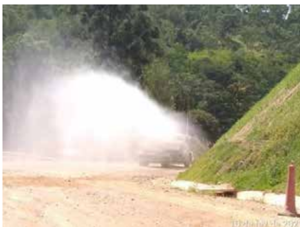
Foto 381 – Umectação nas vias internas. (Data:10/02/2021)
