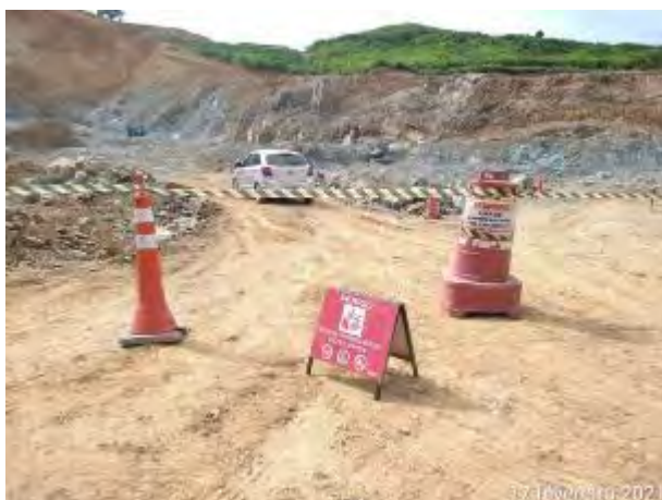
Foto 165 – Sinalização e bloqueio de segurança na área de carregamento de explosivos para o desmorte de rochas. (Data:17/02/2021)
