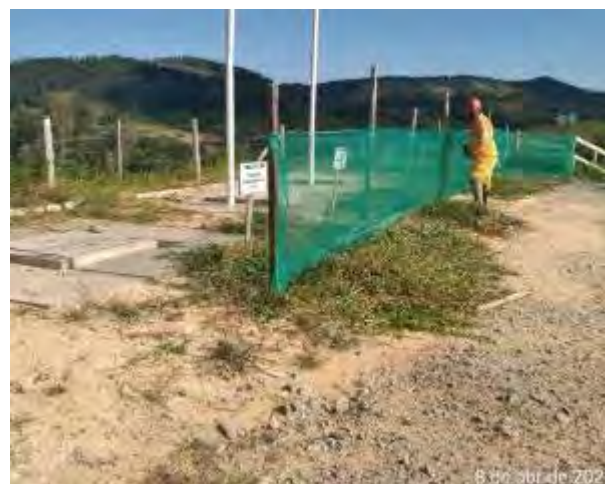
Foto 110- Organização e limpeza em torno de tanque anaeróbico no canteiro operacional. (Data:08/04/2021)
