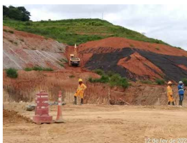
Foto 322 – Regularização de talude do bota-espera margem direita. (Data:12/02/2021)
