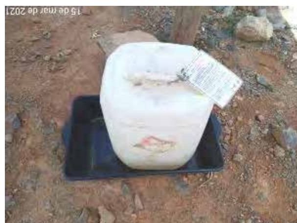
Foto 68 – Produto químico fracionado com rotulagem secundária na frente de serviço com bandeja de contenção. (Data:15/03/2021)
