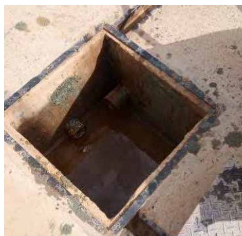
Foto 356 – Inspeção caixa separadora de água/óleo 2. (Data:26/01/2021)
