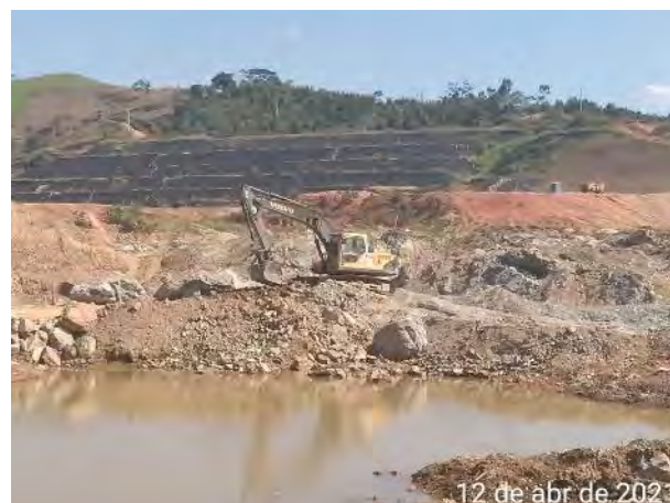
Foto 460 – Movimentação de terra - margem esquerda (Data:12/04/2021)
