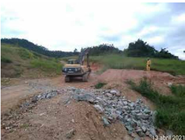
Foto 269 – Manutenção em via interna. (Data:13/04/2021)
