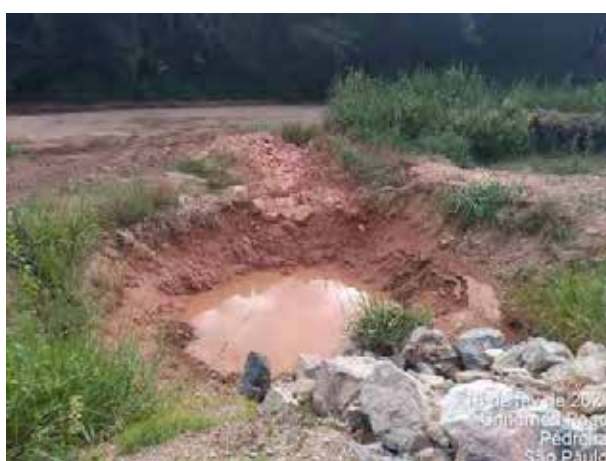
Foto 325 – Inspeção em cacimba - bota-fora VII margem direita. (Data:18/02/2021)
