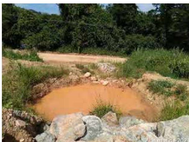
Foto 335 – Inspeção cacimba bota-fora VII M.D. (Data:03/03/2021)
