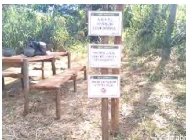
Foto 115 – Limpeza e organização na área de apoio de frente de serviço avançada. (Data:22/04/2021)
