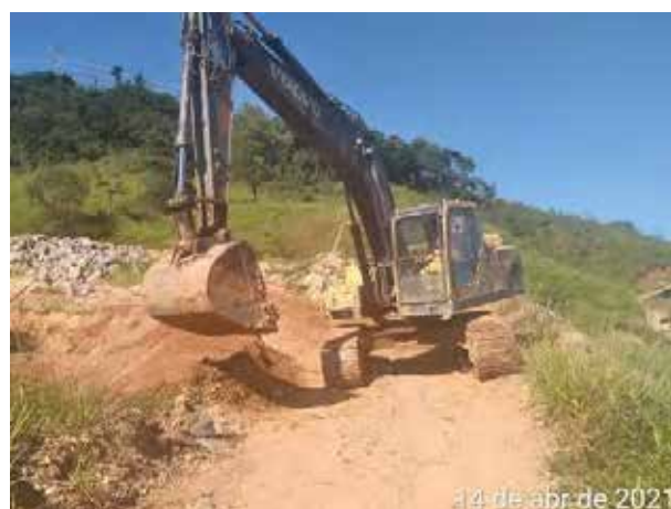
Foto 348 – Limpeza de cacimba – bota-fora III M.D. (Data:14/04/2021)
