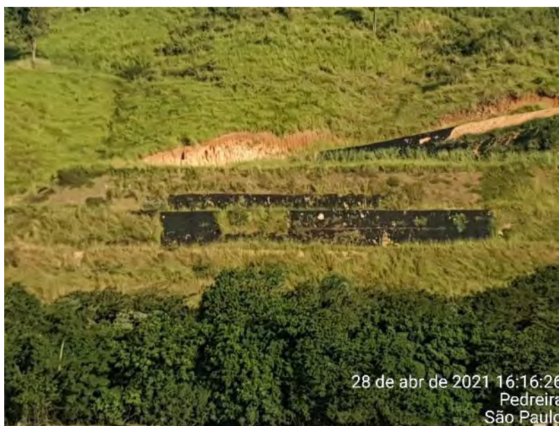
Foto 469 – Bota-fora IV margem direita. (Data:28/04/2021)
