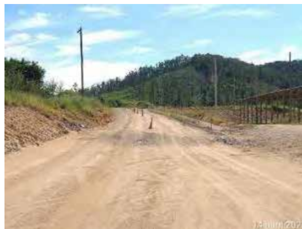
Foto 270 – Sinalização na via interna com cones no canteiro operacional. (Data:14/04/2021)
