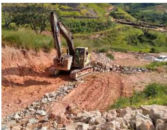
Foto 345 – Regularização – acesso bota-fora VII M.D. (Data:07/04/2021)
