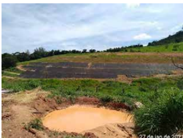
Foto 312 – Inspeção no bota fora III e VII margem direita. (Data:27/01/2021)
