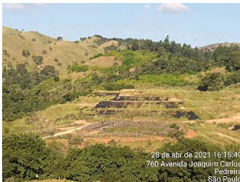
Foto 467 – Bota-fora III Margem Direita. (Data:28/04/2021)
