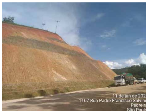
Foto 278 – Utilização de hidrossemeadura em talude da MD 03. (Data:11/01/2021)
