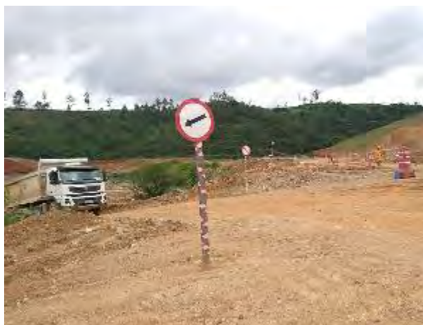
Foto 255 – Sinalização de sentido de via interna na margem esquerda. (Data:08/01/2021)
