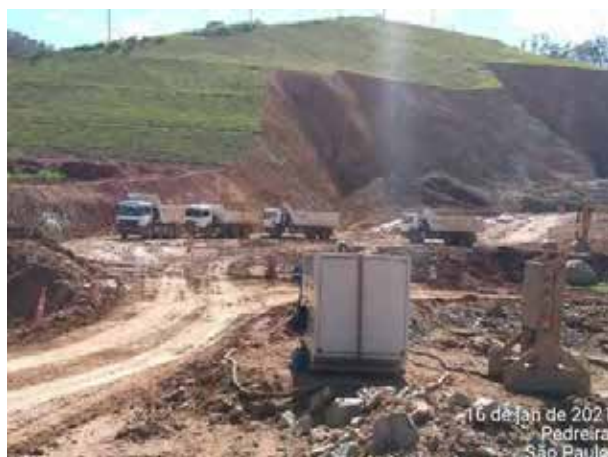
Foto 441 – Movimentação de terra e rocha na margem direita. (Data:16/01/2021)
