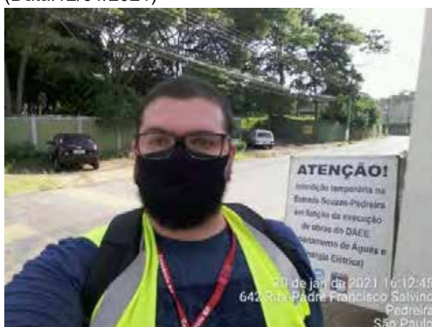
Foto 220– Comunicado da atividade de desmonte de rocha na Rua Padre Francisco Salvano. (Data:20/01/2021)
