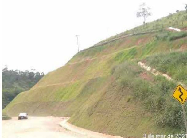
Foto 333 – Inspeção de talude após chuva - acesso M.D.03. (Data:03/03/2021)
