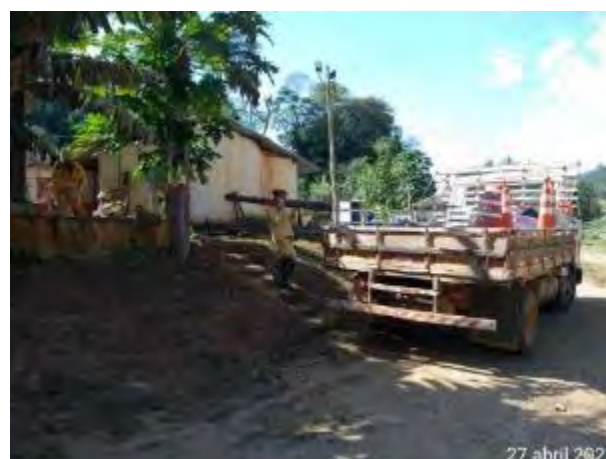
Foto 120 – Limpeza e organização na área do canteiro administrativo. (Data:27/04/2021)
