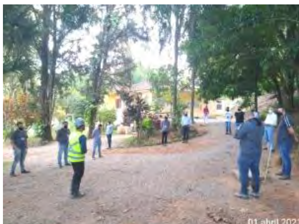
Foto 215 – DDS geral sobre desmonte de rochas no canteiro administrativo. (Data:01/04/2021)
