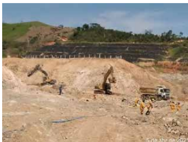
Foto 457 – Movimentação de terra - margem esquerda. (Data:05/04/2021)
