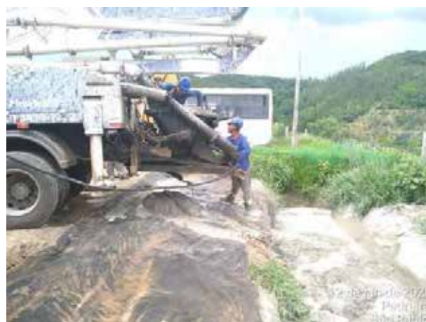
Foto 354 – Lavagem da calha de betoneira. (Data:12/01/2021)
