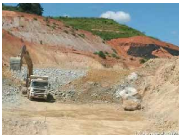
Foto 453 – Movimentação de terra e rocha - margem direita próximo ao eixo. (Data:15/03/2021)
