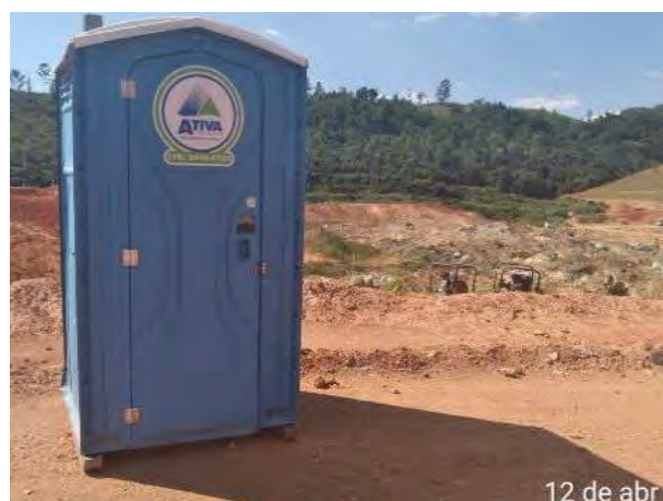
Foto 374 – Banheiro químico instalado na frente de serviço – ombreira direita. (Data:12/04/2021)
