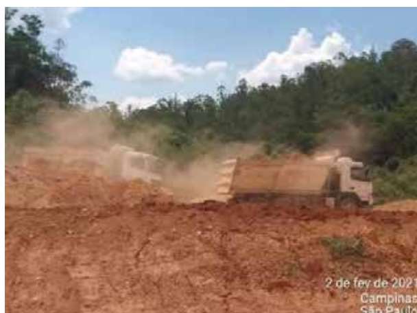
Foto 443 – Movimentação de terra do empreendimento. (Data:02/02/2021)
