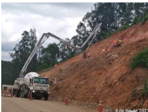
Foto 277 – Concretagem de canaleta de crista - talude da MD03. (Data:08/01/2021)
