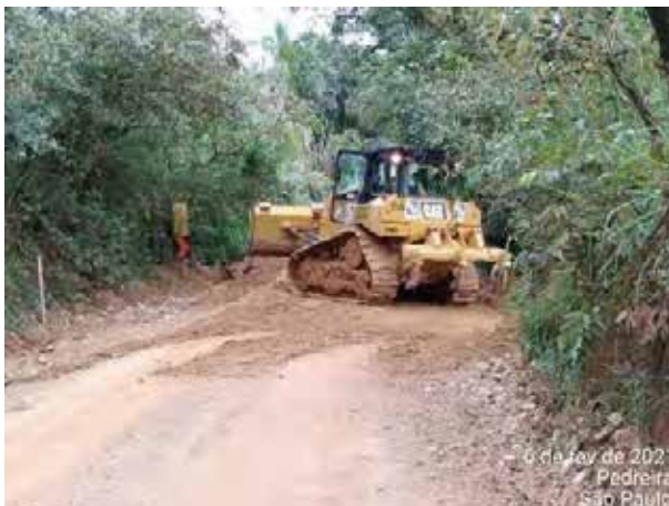
Foto 261 – Manutenção em via interna. (Data:06/02/2021)
