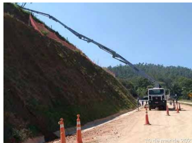
Foto 286 – Concretagem em crista de talude no acesso MD03. (Data:10/03/2021)
