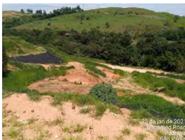
Foto 311 – Inspeção em bota-fora IIIA na margem direita. (Data:25/01/2021)
