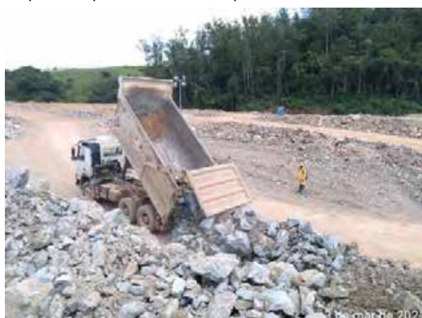
Foto 449 – Movimentação de rocha do empreendimento na margem esquerda. (Data:03/03/2021)
