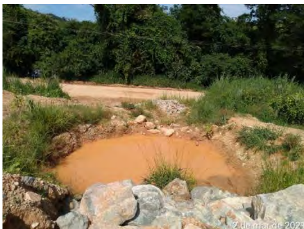
Foto 285 – Cacimba no bota fora IV atendendo a captação de água pluvial. (Data:02/03/2021)
