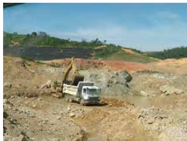
Foto 442 – Movimentação de terra na margem direita. (Data:21/01/2021)
