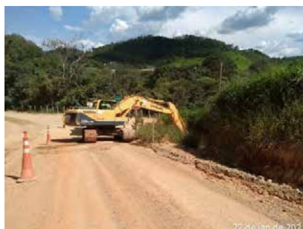
Foto 308 – Limpeza de cacimba no acesso ao canteiro administrativo. (Data:22/01/2021)
