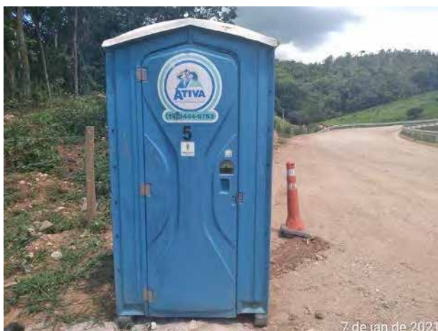
Foto 365 – Banheiro químico instalado na frente de serviço - acesso M.D. 03. (Data:07/01/2021)
