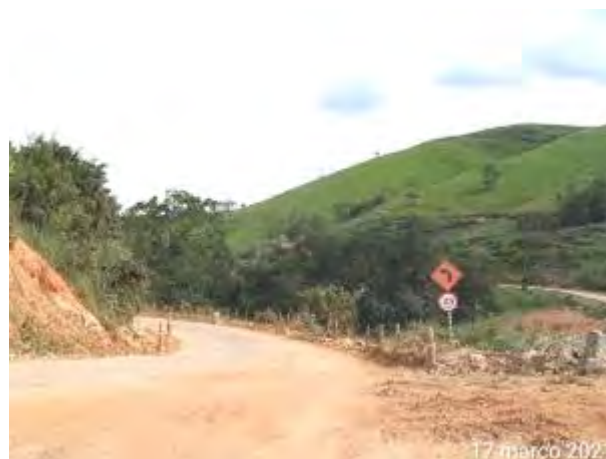
Foto 266 – Sinalização de curva acentuada a esquerda e limite de velocidade de via interna. (Data:17/03/2021)
