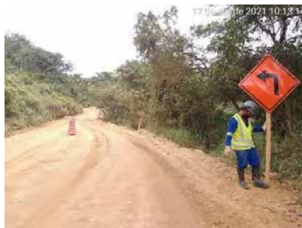
Foto 272 – Instalação de placa de curva acentuada. (Data:17/04/2021)
