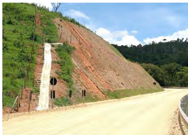
Foto 276 – Canaleta de crista em talude da MD03. (Data:05/01/2021)
