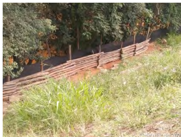
Foto 334 – Inspeção em contenção ambiental na M.D.03. (Data:03/03/2021)
