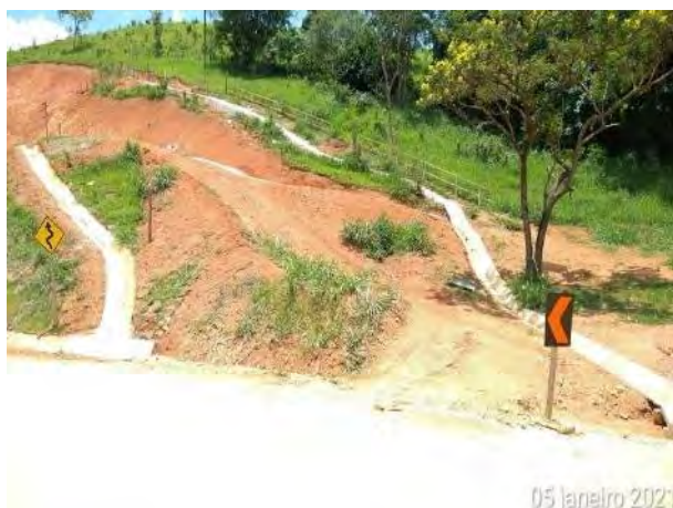
Foto 275 – Drenagem definitiva em talude na MD 03. (Data:05/01/2021)
