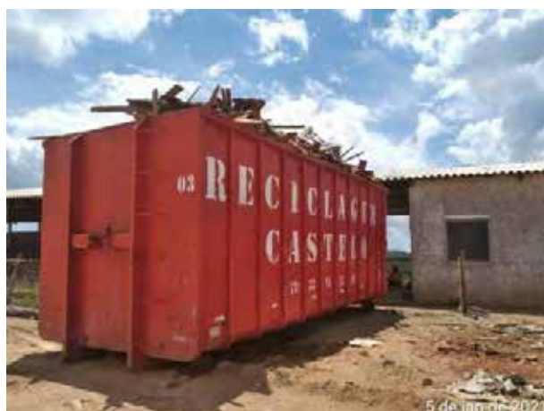
Foto 409 – Caçamba de resíduos de madeira no canteiro operacional. (Data:05/01/2021)
