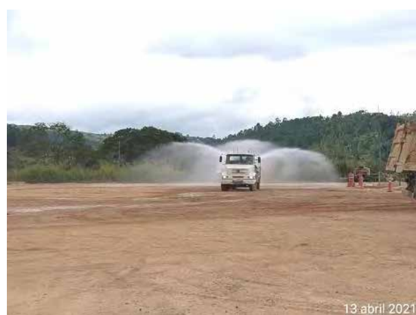
Foto 388 – Umectação nas vias internas. (Data:13/04/2021)
