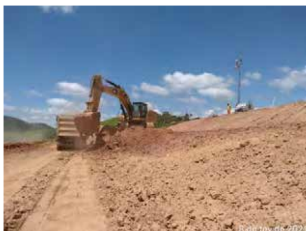
Foto 447 – Movimentação de terra margem esquerda. (Data:08/02/2021)
