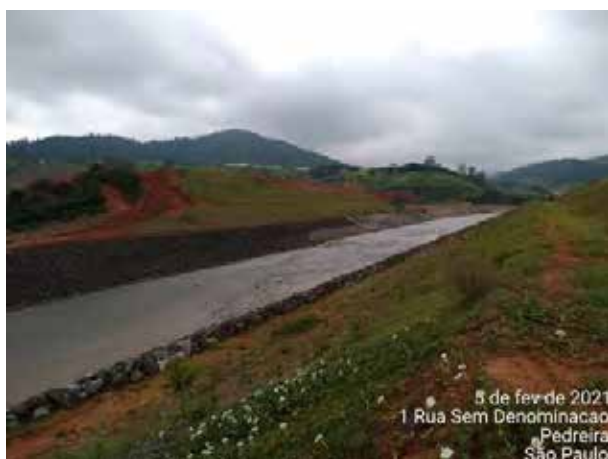
Foto 315 – Inspeção em talude de corte da margem esquerda e canal de desvio. (Data:05/02/2021)
