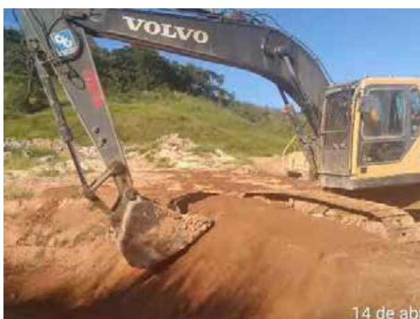
Foto 349 – Limpeza de cacimba – bota-fora III M.D. (Data:14/04/2021)
