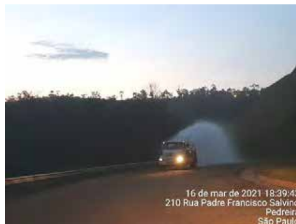
Foto 384 – Umectação nas vias internas. (Data:16/03/2021)
