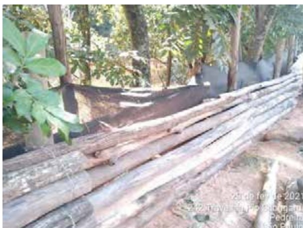
Foto 327 – Reforço na estrutura da contenção ambiental com madeiras. (Data:23/02/2021)
