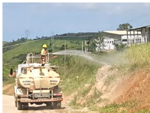
Foto 343 – Irrigação de grama em talude – acesso M.D.01. (Data:05/04/2021)
