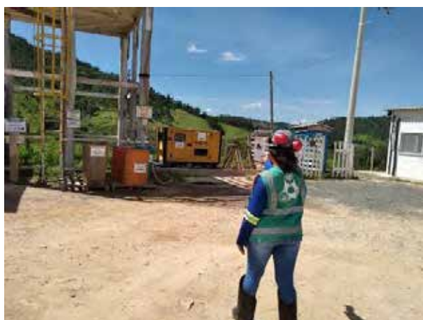
Foto 395 – Medição de fumaça preta no gerador do canteiro operacional. (Data:22/02/2021)
