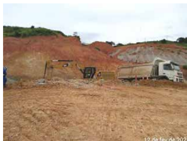
Foto 448 – Movimentação de terra na margem direita. (Data:12/02/2021)
