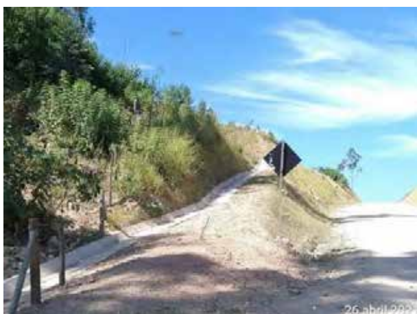
Foto 291 – Dispositivo de drenagem definitiva no acesso MD03. (Data:26/04/2021)
