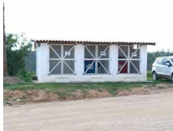
Foto 416 – Baia de resíduos recicláveis no canteiro operacional. (Data:08/02/2021)
