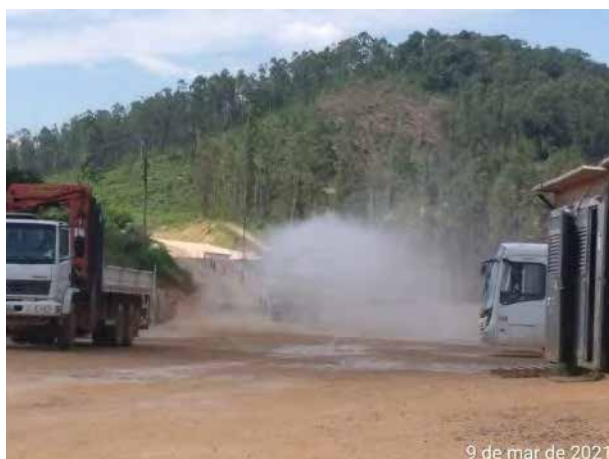
Foto 383 – Umectação nas vias internas. (Data:09/03/2021)
