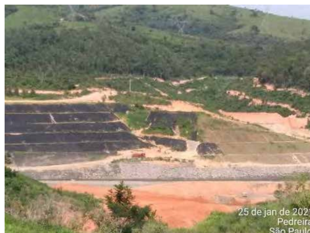
Foto 310 – Inspeção no bota fora I margem esquerda. (Data:25/01/2021)
