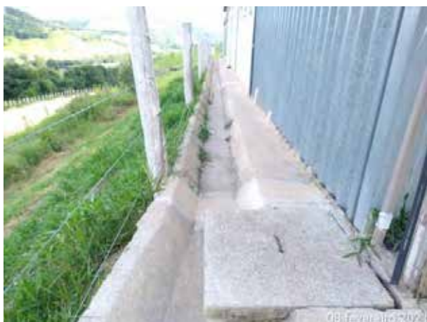
Foto 283 – Drenagem provisória no canteiro operacional. (Data:08/02/2021)
