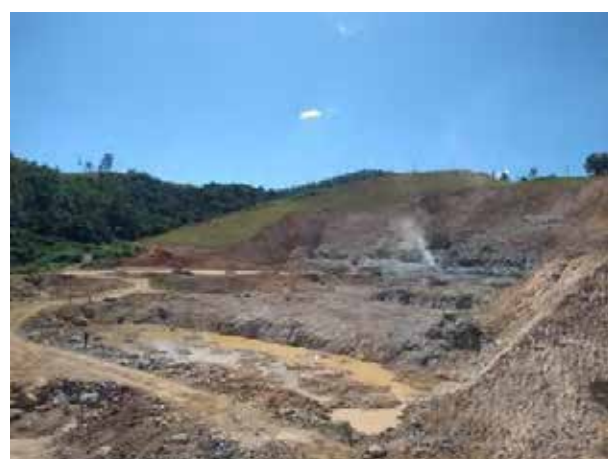
Foto 456 – Movimentação de terra e rocha - margem direita. (Data:06/04/2021)
