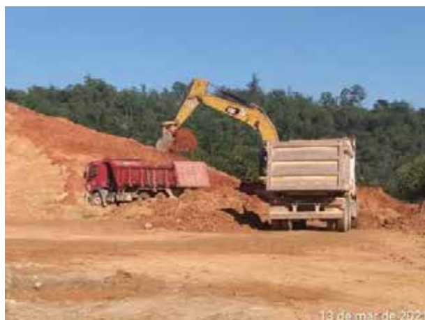
Foto 451 – Movimentação de terra na margem esquerda. (Data:13/03/2021)
