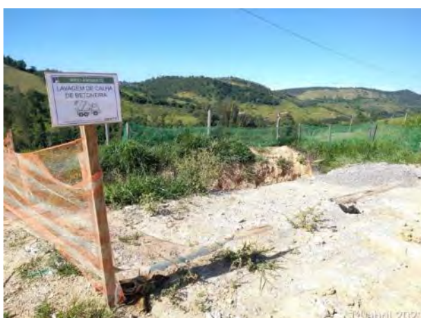
Foto 361 – Lavagem da calha da betoneira. (Data:14/04/2021)
