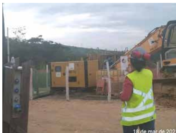
Foto 396 – Medição de fumaça preta no gerador da oficina mecânica. (Data:18/03/2021)
