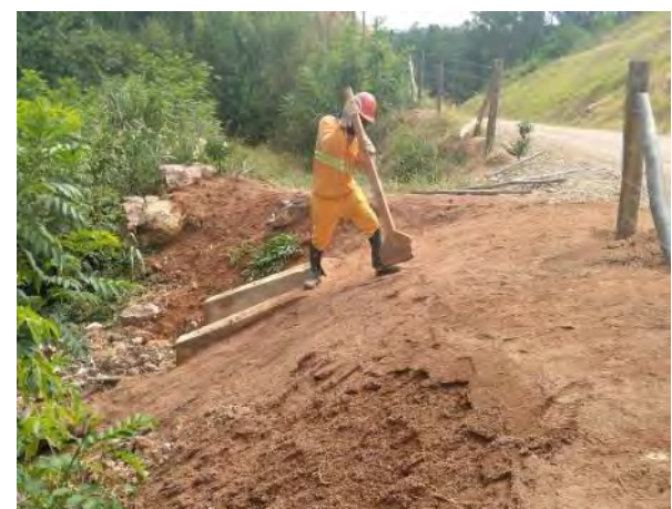
Foto 344 – Adequação de talude – acesso M.D.03. (Data:07/04/2021)
