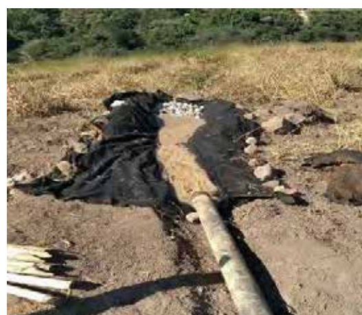
Foto 364 – Dispositivo de drenagem para efluente do processo de sondagem. (Data:30/04/2021)
