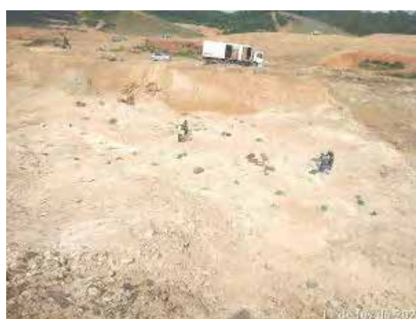
Foto 164 – Área de carregamento dos explosivos para o desmonte de rocha. (Data:11/02/2021)
