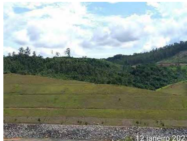
Foto 302 – Inspeção em talude de corte da Margem Direita. (Data:12/01/2021)
