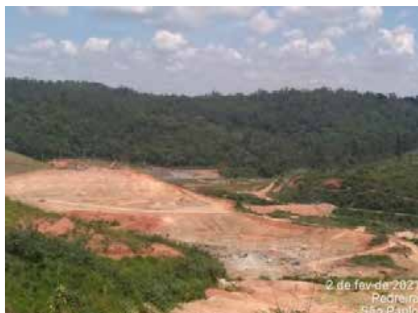
Foto 445 – Movimentação de rocha e terra do empreendimento. (Data:02/02/2021)
