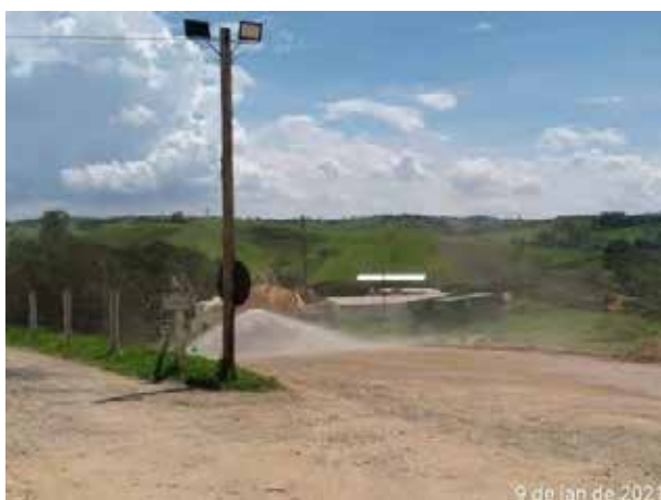
Foto 379 – Umectação nas vias internas. (Data:09/01/2021)
