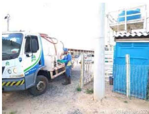
Foto 368 – Higienização do banheiro químico - canteiro operacional. (Data:08/02/2021)
