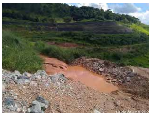
Foto 326 – Inspeção em cacimba - bota-fora VII margem direita. (Data:18/02/2021)
