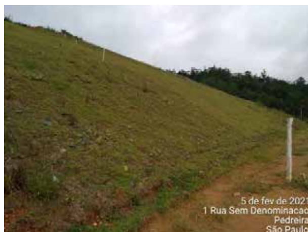
Foto 316 – Inspeção em talude de corte da margem esquerda. (Data:05/02/2021)
