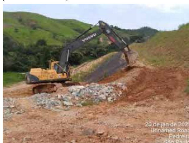
Foto 306 – Regularização de talude. Bota-fora VII MD. (Data:20/01/2021)
