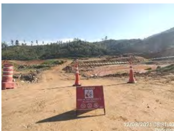
Foto 169 – Sinalização de segurança na área de carregamento de explosivos para o desmorte de rochas. (Data:12/03/2021)
