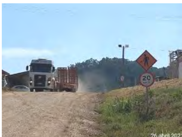
Foto 273 – Sinalização de limite de velocidade no canteiro operacional. (Data:26/04/2021)
