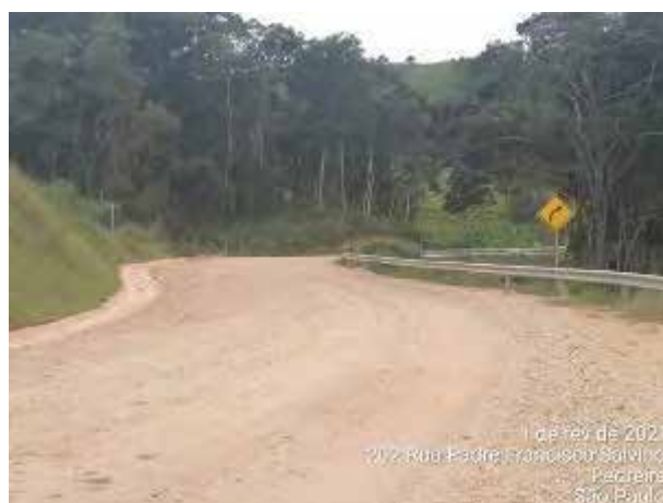
Foto 245 – Sinalização de curva acentuada a direita no acesso a MD03. (Data:01/02/2021)
