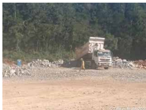
Foto 454 – Movimentação de terra - bota-fora II M.E. (Data:27/03/2021)
