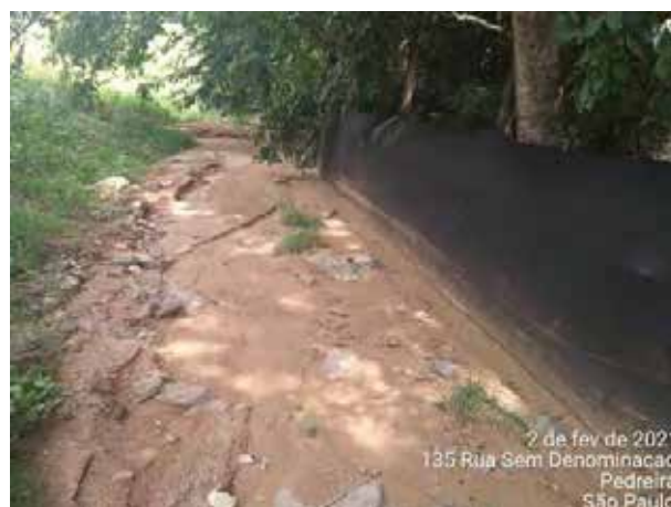
Foto 313 – Inspeção em contenção ambiental do acesso MD03. (Data:02/02/2021)
