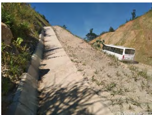
Foto 289 – Dispositivo de drenagem definitiva no acesso MD03. (Data:01/04/2021)
