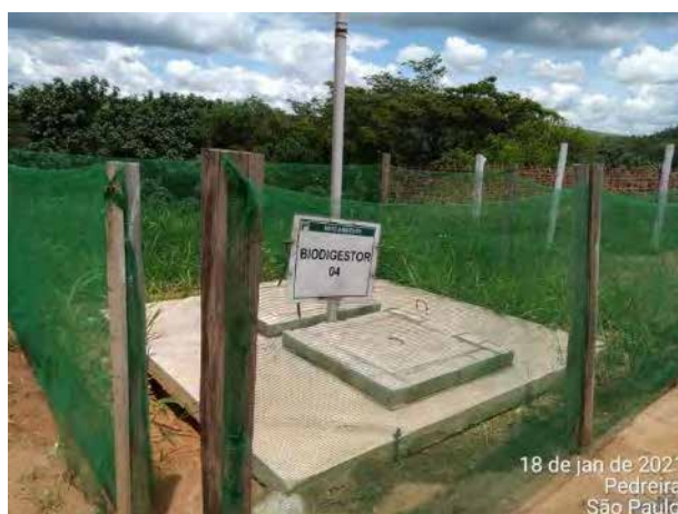
Foto 375 – Biodigestor 4 no canteiro operacional. (Data:18/01/2021)
