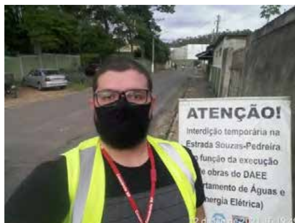
Foto 218– Comunicado da atividade de desmonte de rocha na Rua Padre Francisco Salvano. (Data:12/01/2021)
