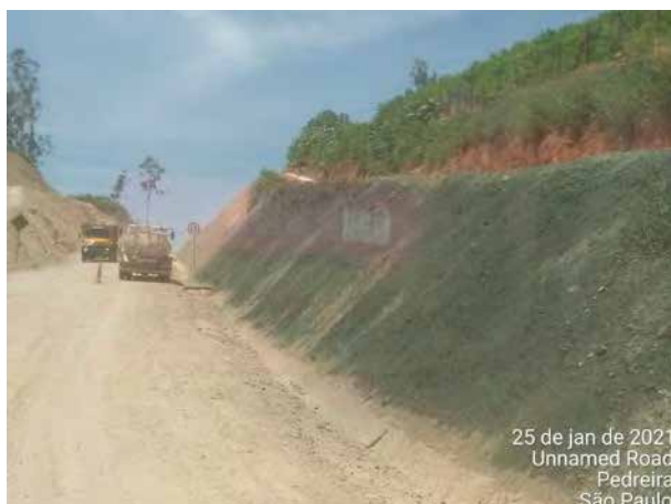
Foto 309 – Inspeção de talude no acesso MD03. (Data:25/01/2021)
