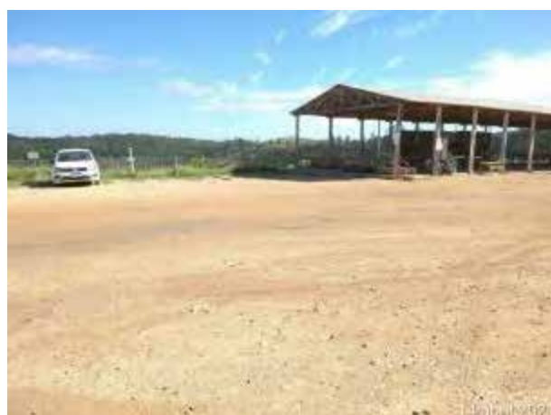
Foto 113 – Organização e limpeza no canteiro operacional. (Data:13/04/2021)
