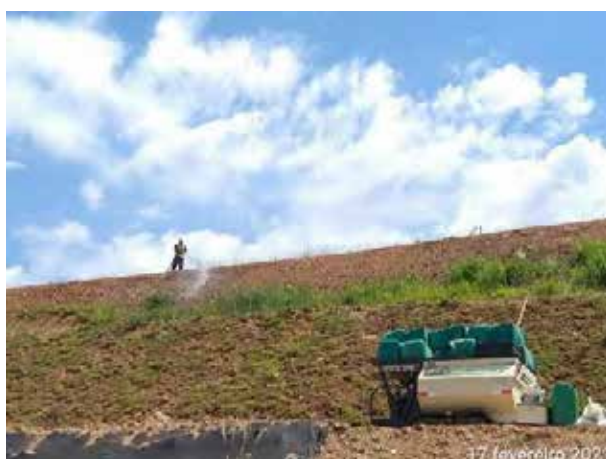
Foto 323 – Aplicação de hidrossemeadura no bota-fora IIA margem esquerda. (Data:17/02/2021)
