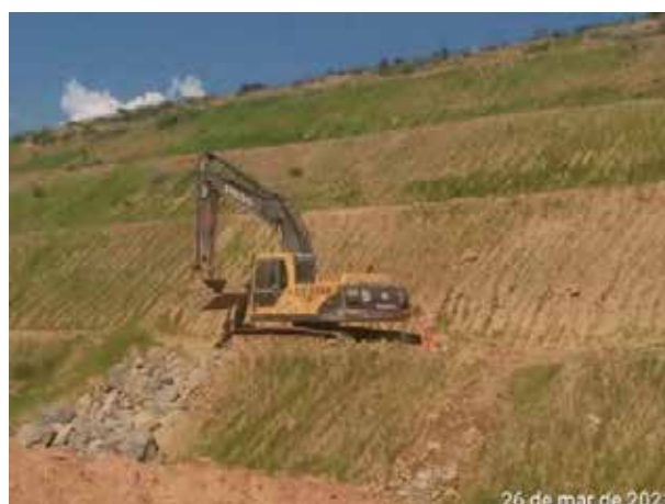
Foto 342 – Regularização de talude – acesso bota-fora II na M.E. (Data:26/03/2021)
