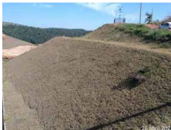
Foto 352 – Inspeção em talude de corte - ombreira direita. (Data:26/04/2021)
