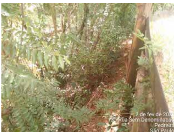
Foto 314 – Inspeção atrás da contenção ambiental do acesso MD03. (Data:02/02/2021)
