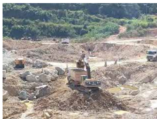
Foto 462 – Movimentação de terra - margem direita (Data:26/04/2021)
