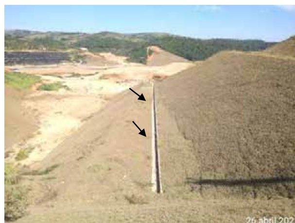
Foto 296 – Canaleta de crista em talude de corte na ombreira direita. (Data:26/04/2021)
